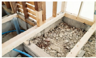
腐食部分交換
